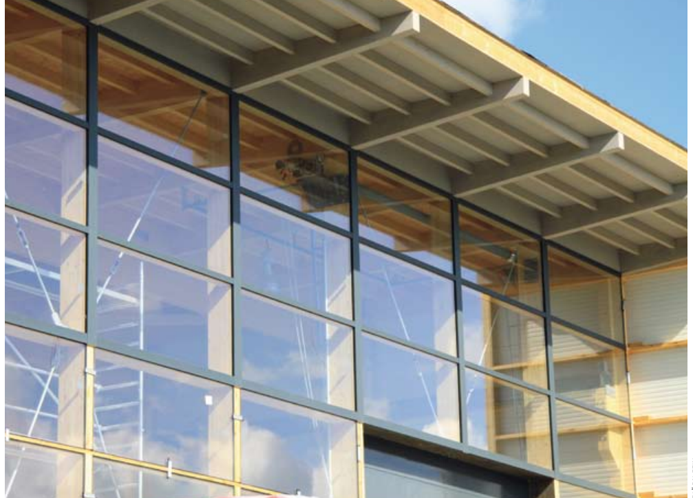
▲ Holz und Glas prägen die Fassade der Werkhalle in Form einer großflächigen Pfosten-Riegelfassade
