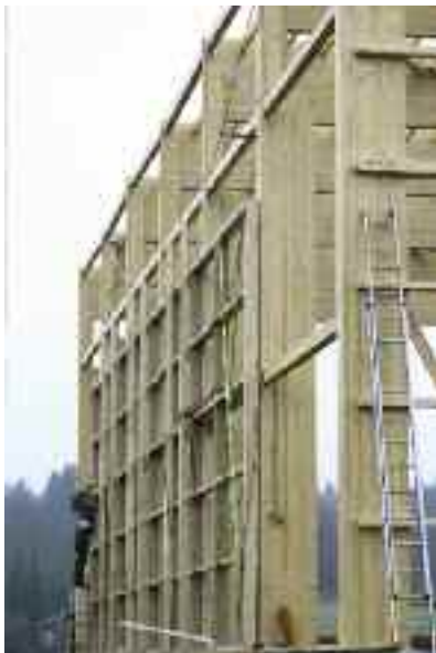
Montage der Südfassade © Markus Reimann
