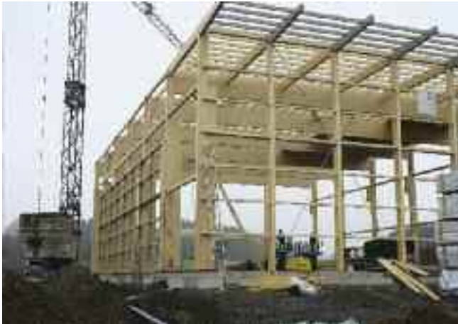
Errichtung der Holzkonstruktion © Markus Reimann
